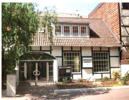
Das Gemeinschaftshaus - die Fenster bedurften einer dringenden Renovierung
