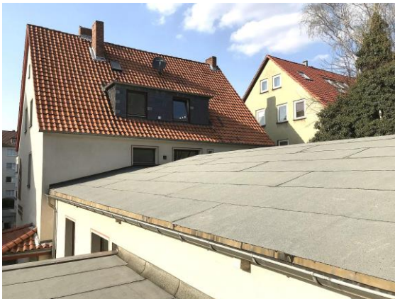
Das instandgesetzte Saaldach
