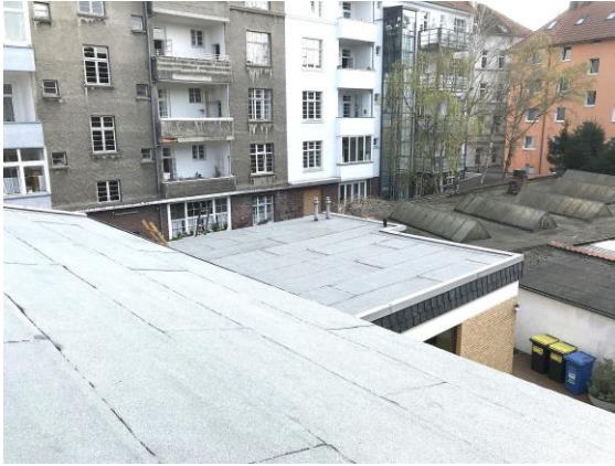
Das instandgesetzte Dach des EC-Anbaues mit der neuen Schieferverkleidung
